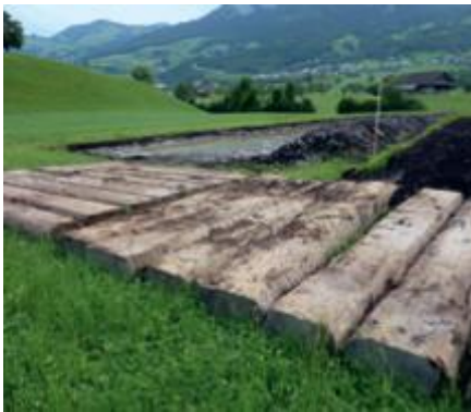
Baggermatratze aus Holz zur Verteilung des Maschinengewichts (z.B. Bagger) und so zur Verminderung von Bodenverdichtung.
